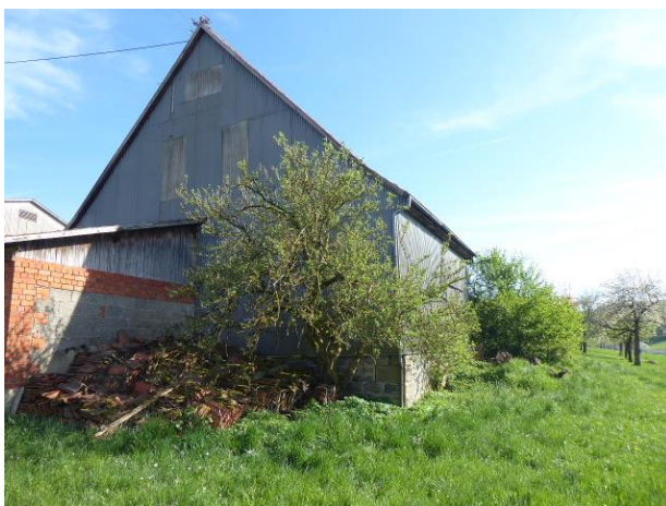
Abb. 4: Blick auf die Scheune von Flst.-Nr. 53/1 aus nördlicher Richtung mit gelagerten Dachziegeln und Gehölz.
