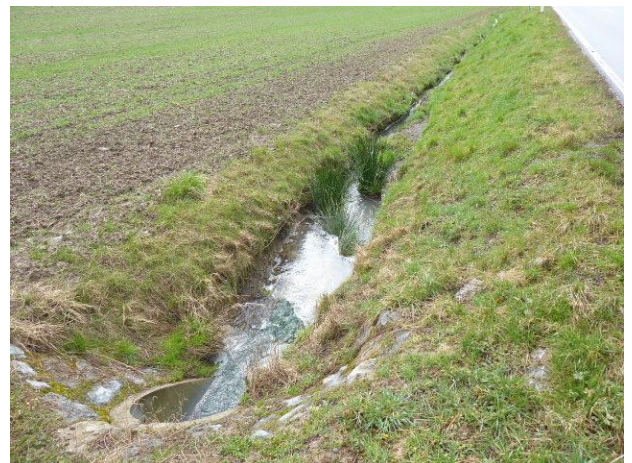
Abb. 15: Entwässerungsgraben zwischen Pfahlbacher Straße und Plangebiet nach Starkregen.
