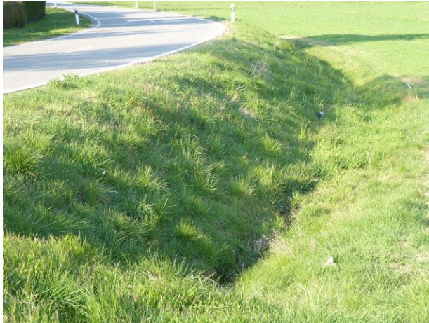
Abb. 16: Entwässerungsgraben zwischen Pfahlbacher Straße und Plangebiet ohne Wasserführung.
