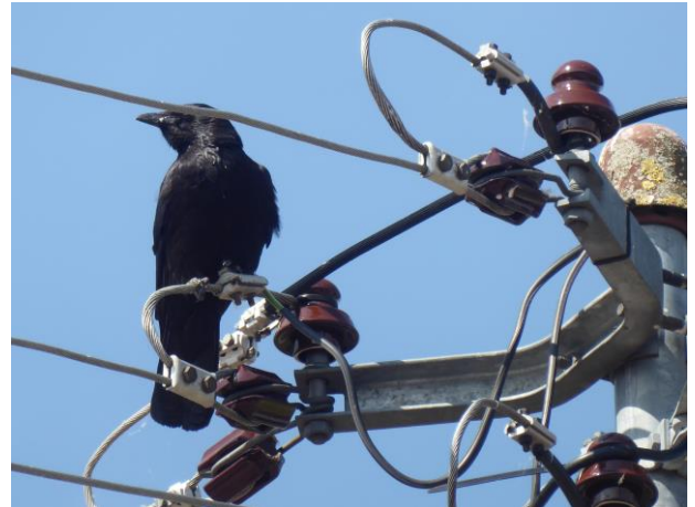
Abb. 26: Aaskrhe auf kleinem Freileitungsmast auf einem Hausdach stlich des Plangebiets.
